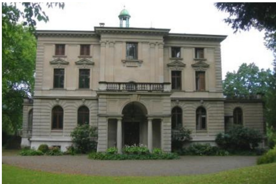
Villa Wegmann, Hohenbühlstr. 15, 8008 Zürich (Photo: Gebr. Dürst)
